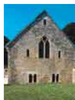
FONTENAY (Côte-d'Or, Bourgogne). Le mur pignon sud de la chapelle des étrangers (xii e s.) restaurée au xx e siècle.
