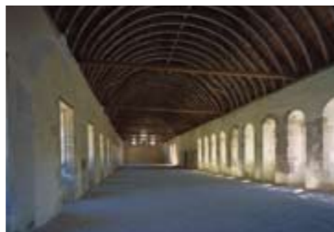
FONTENAY (France, Bourgogne, Côte-d'Or). Le dortoir des moines (XII e s.). Les larges ouvertures sont tardives (XVIII e s.) ; celles d'origine étaient beaucoup plus étroites.
